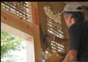
土壁は塗壁とも呼び、職人の手作業により、土を塗り重ねていきます。
